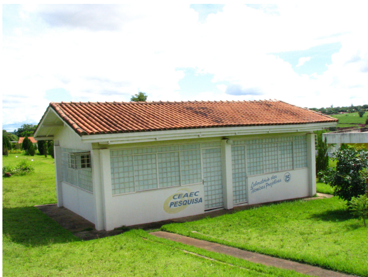
Projetárium do Ceac em Foz do Iguaçu, PR. Foto do autor, dez 2009.
